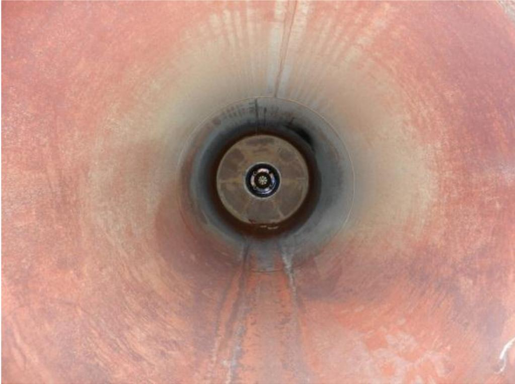
**Abbildung 3-3: Flammrohr vor Einbau der HTS mit Sicht auf den Brenner (Quelle: Klaus Lehmann, MoonPower)**
